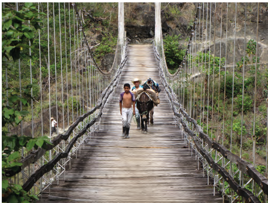
Transitando el puente “La Garrucha” (David Higueta, Jorge, 2013)
