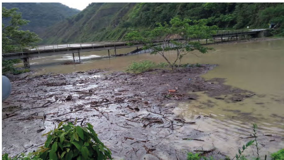
Figura 4. Puente Pescadero en proceso de inundación por la represa de Hidroituango en mayo de 2018. Fuente: Abelardo David Chanci, Cabildo Nutabe de Orobajo, 2018.
