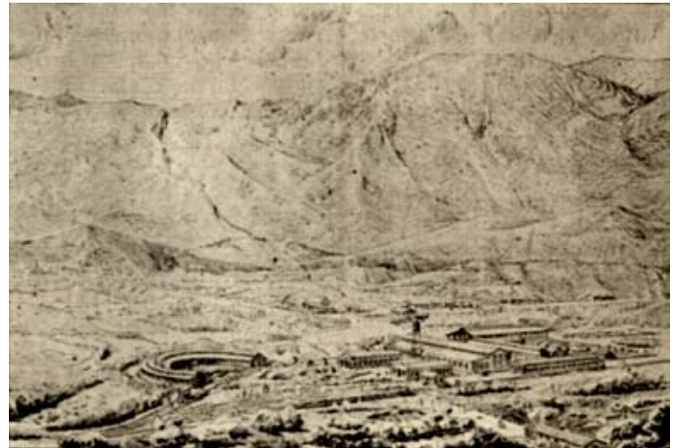
Talleres del Ferrocarril de Antioquia en Bello, junto al proyecto del barrio Nueva Manchester en 1923. Exposición de Antioquia Industrial, agrícola y pecuaria , Medellín, Vieco, 1923. (8 B. - Publicidad del Barrio Nueva Manchester)
